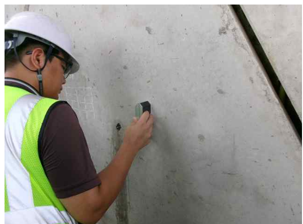
경사계를 이용한 경사도 측정
